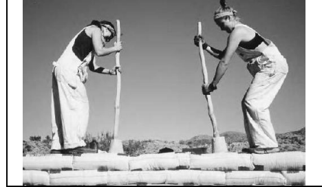
الدك بالمطرقة لأكياس التربة المصدر: K.Hunter & D.Kiffmeyer, (2004)p38.
