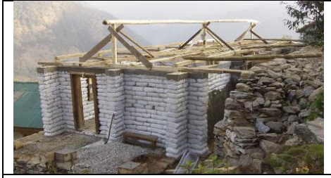
تركيب الجمالون الخشب علي كمرات الربط.
