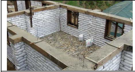
صب الكمرات الخرسانية لربط الحوائط وكذلك الأكتاف.
