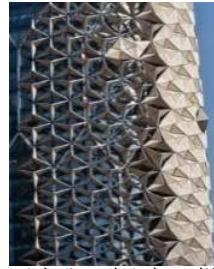
شكل (52) الزجاج المزود ذات الغلاف الخارجي المتحرك.
