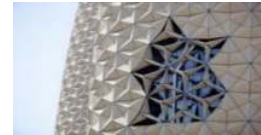
شكل (8) أبراج البحار في أبو ظبي كمثال للتحكم الذكي في عملية الظلال بكاسرات أشعة الشمس.
