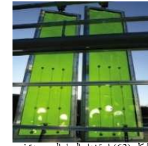
شكل (63) استخدام المياه الموجودة في ألواح مبنى BIQ في توليد الطاقة وتخزينها.
