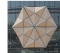
شكل (53) الكاسرات المتحركة المصنوعة من الألياف الزجاجية المطلية ب PTFE في مبنى أبراج البحر.
