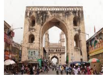
شكل (10) تدهور البنية الهيكلية للمباني
